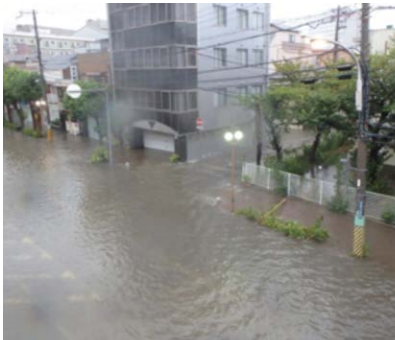
東川崎地区の浸水被害（堤内地）
