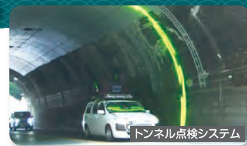
トンネル点検システム
